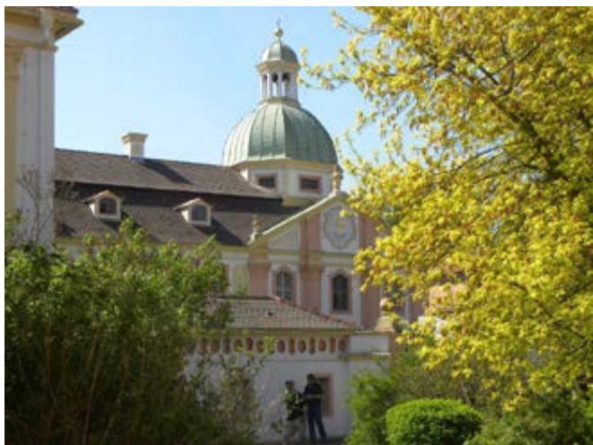
Rokoková kaple sv. Kříže a sv. Michaela v klášteře Mařidolu, která byla letos po dlouhé době znovu zpřístupněna veřejnosti, byla totiž zničena při velké povodni, jež klášter postihla v srpnu 2010, foto Jan Zdichynec
