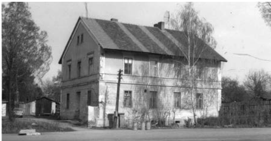
Celková situace domu v roce 1993 před umístěním desky, foto archiv SPL
